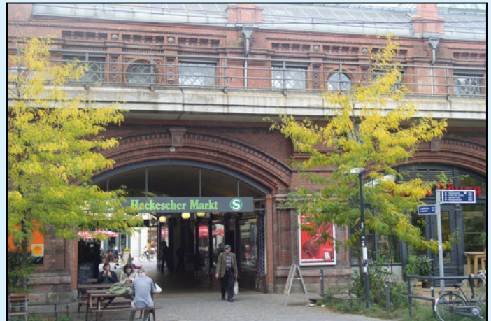
Die Bahnbögen im heutigen Zustand
